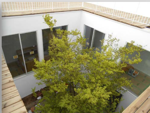
工事中写真 中庭をルーフテラスより撮影(2023.4)
