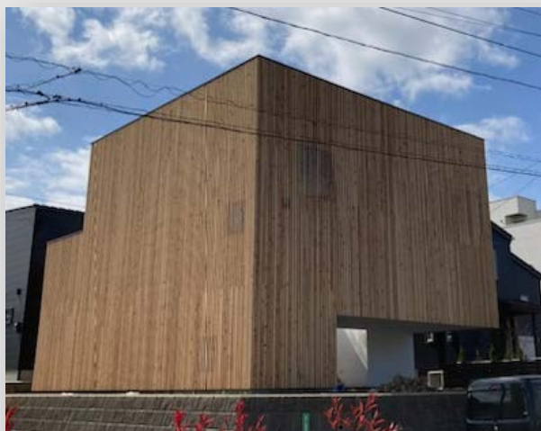
工事中写真 外観撮影(2023.4)
